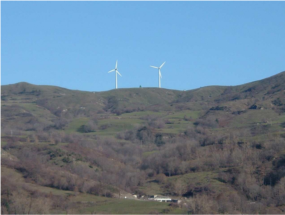
Varese Ligure (SP) – Impianto Energia Eolica
